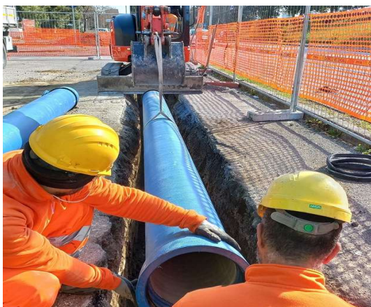
Sostituzione di 24 km di condotte obsolete
